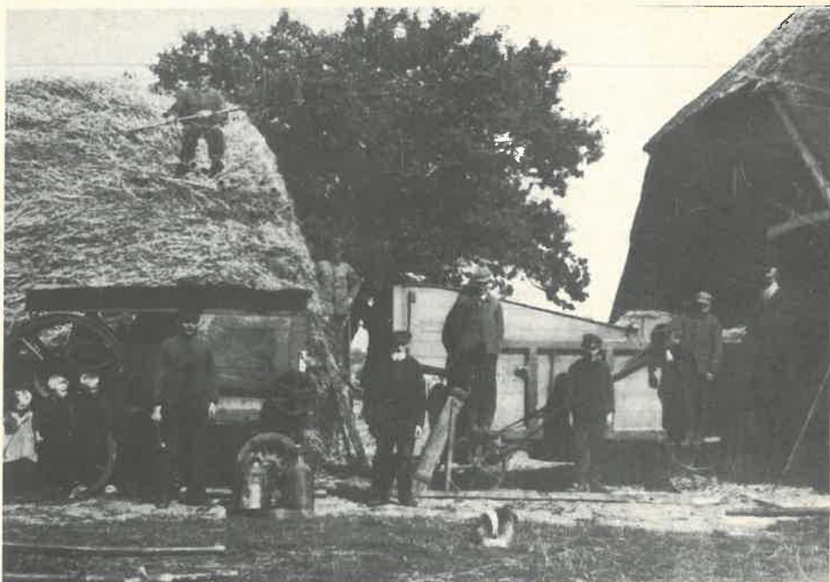
Dreschen – Eine Dampfmaschine treibt die Dreschmaschine an
