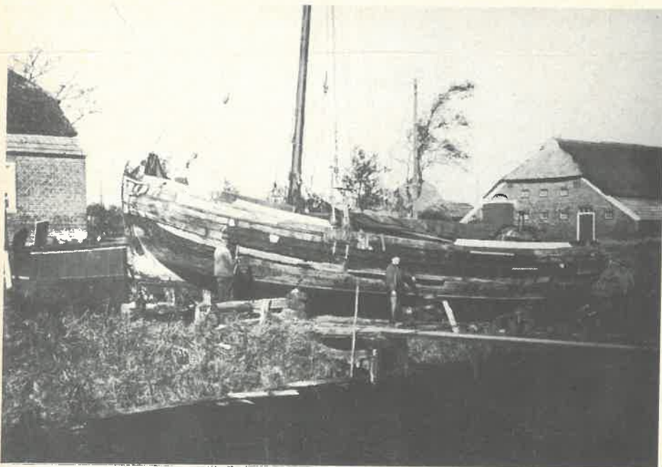
Eine Tjalk liegt zur Reparatur auf dem „Helgen“
